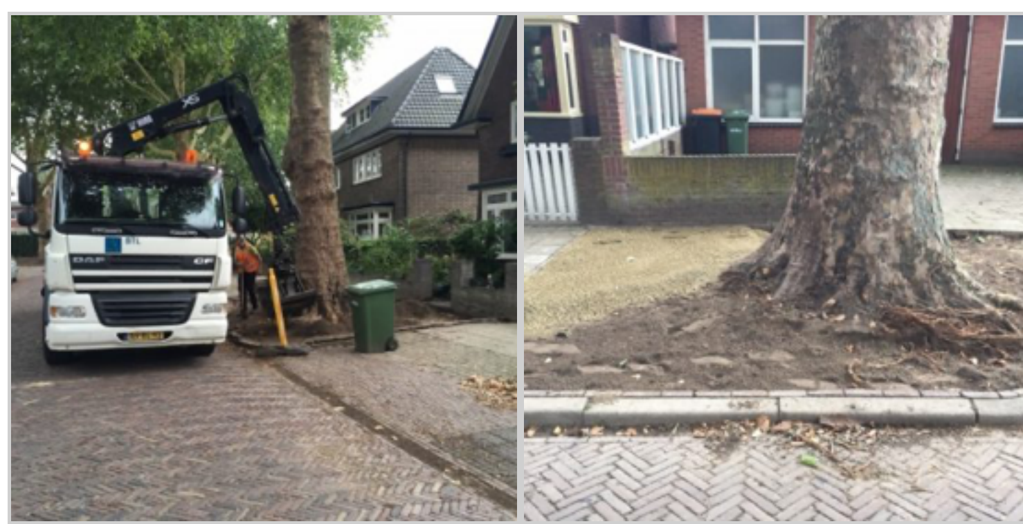
aanbrengen halfverharding
